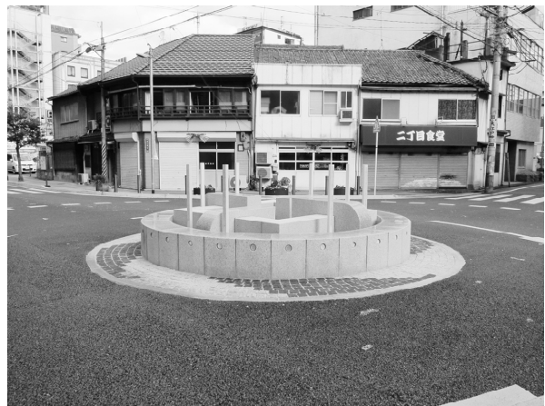
写真-6 改修整備後のロータリー
