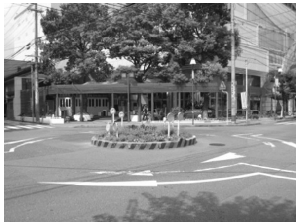
写真-5 改修整備前のロータリー
