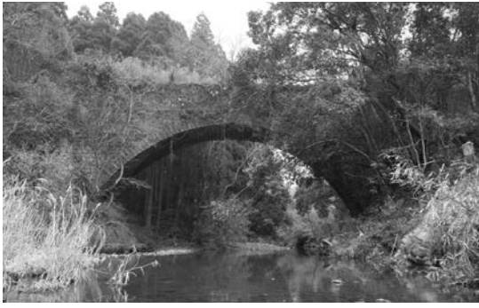
図-9：昭和井路伏越橋（撮影：寺村）
