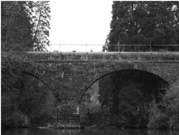
図-2：一号幹線第二拱石橋(撮影：寺村)
