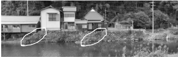
図-7 階段を用いて鋸状に河岸を張り出している
