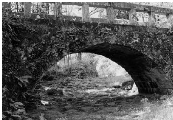
写真-3 産神社前眼鏡橋 10) （熊本県、石造上路充腹アーチ橋）
