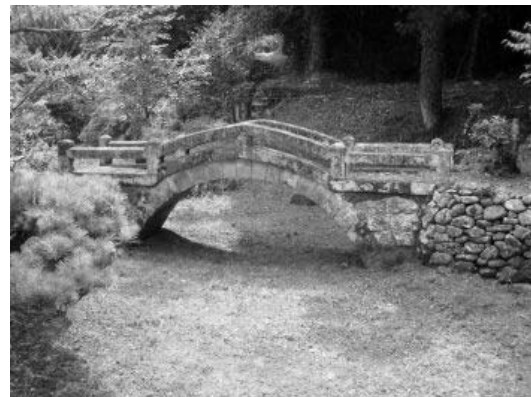
写真6 来迎寺境内橋 14) （大分県、石造アーチ橋）
