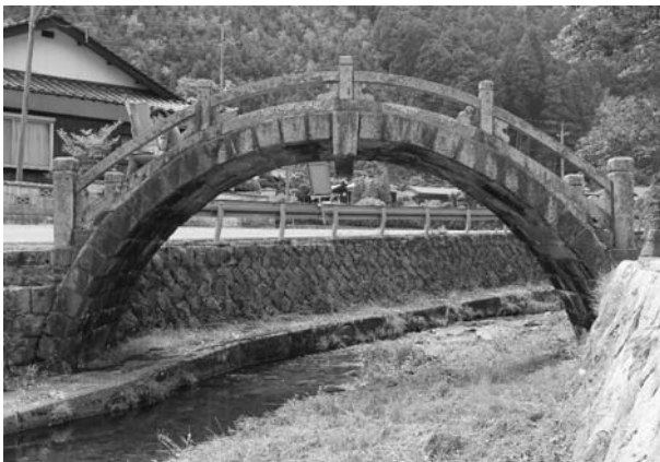
写真-1 現在の穹崇橋（下流側左岸より）
