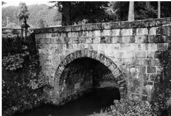
写真5 大虫神社宮橋 13) （福井県、石造上路充腹アーチ橋）
