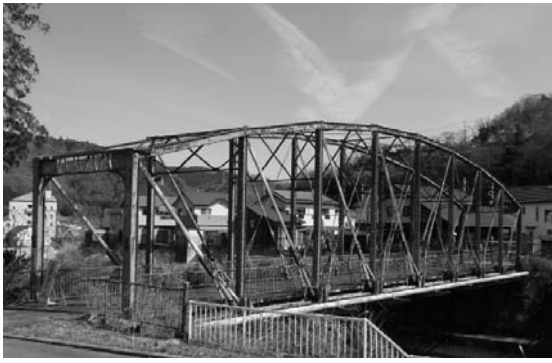
写真1 森村橋全景（鮎沢川左岸（工場内）上流側より） （撮影 2015 年 2 月）
