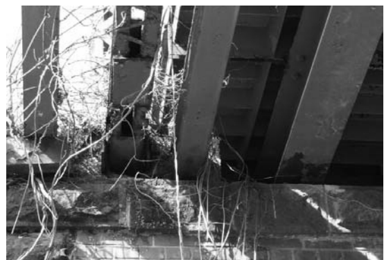
写真13 支点部付近 端横桁に接続する追加された下弦材, 縦桁は端横桁とともにコンクリートで覆われている
