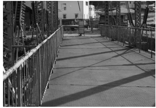
写真11 床版(1) 縞鋼板をデッキプレートとして裏面をFBのリブで補剛
