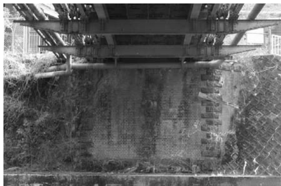
写真10 ブラケットと一体となった横桁 弦材の下側に取りつくブラケットと一体となった横桁 ブラケットには添加のパイプが載っている。レンガ、石造の橋台が背後に見える
