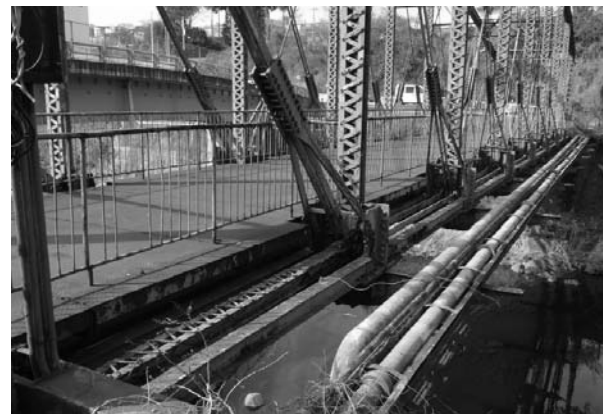
写真3 補強された斜材，下弦材
