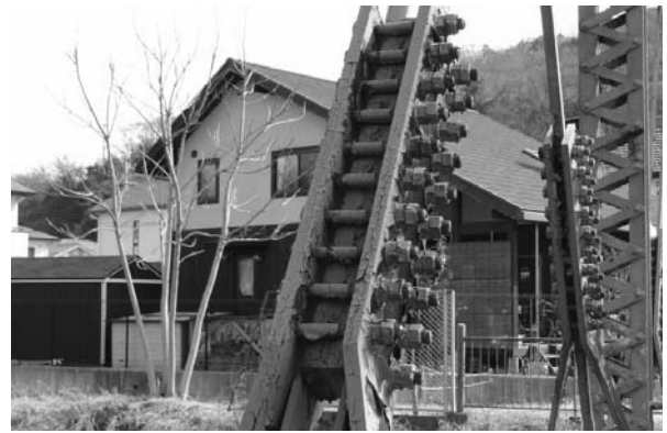
写真7 斜材の継手部
