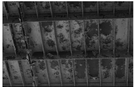
写真12 床版(2) 床版裏面のリブとパネル継手（横方向が橋軸）
