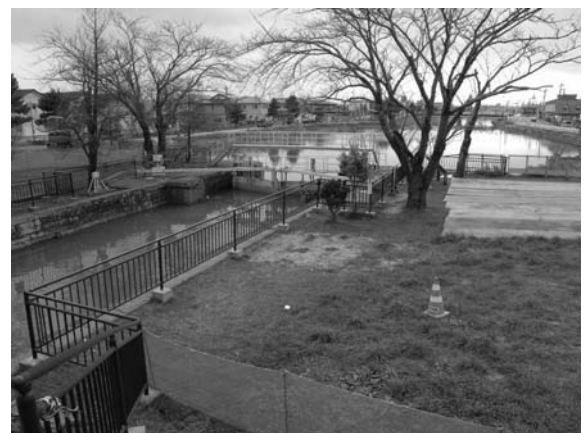
図-4 石井閘門の閘室部（右岸上流側から撮影） 保全対策工事に向けた準備が進められている （撮影：阿部，2013.10.31）
