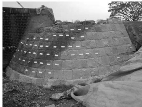
図-15 横利根閘門の護岸石積みの補修状況 （撮影：阿部，2013.11.15）
