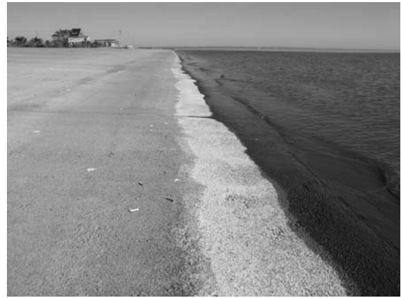
図-19 復旧後の霞ヶ浦湖岸施設南側滑走台 (撮影：阿部，2013.11.22)
