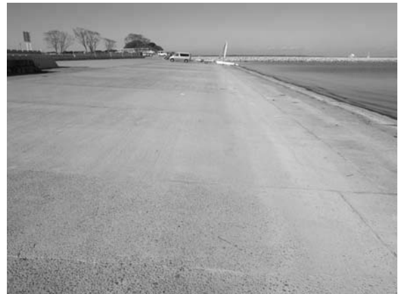
図-20 復旧後の霞ヶ浦湖岸施設東側滑走台 (撮影：阿部，2013.11.22)
