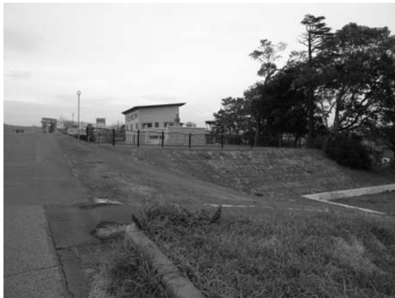
図-18 地盤改良が行われた中川吉造胸像所周辺の護岸 (撮影：阿部，2013.11.15)
