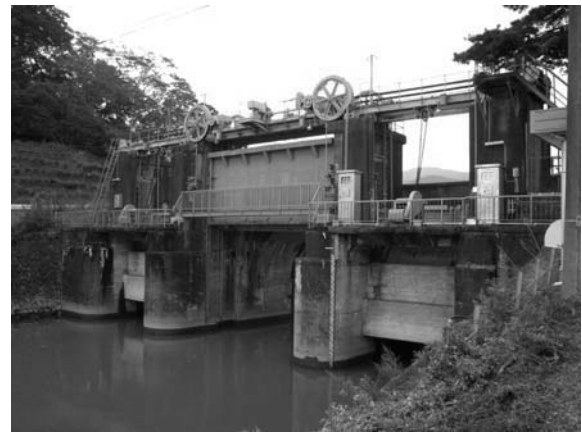
図-10 福地水門（下流左岸側から撮影） 前回調査実施時とほぼ同様の状態にある （撮影：阿部，2013.10.31）
