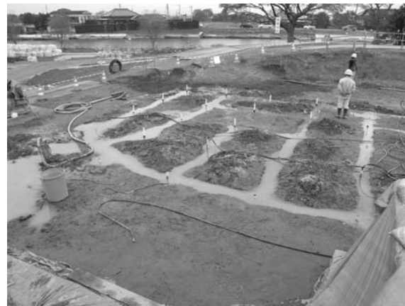
図-14 横利根閘門左岸上流側護岸の地盤対策工事の状況 （撮影：阿部，2013.11.15）
