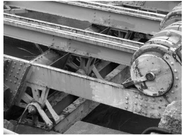
図-7 月浜第二水門のバランスゲートの支承部 中央2か所の支承部で転用工事が行われた (撮影：阿部，2013.10.31)
