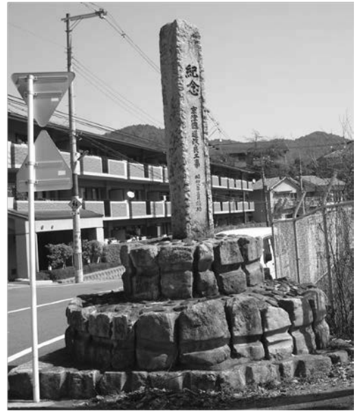
写真-2.1.4 京津国道改良工事記念碑（京都市山科区日ノ岡，昭和8年3月竣工）の台石に再利用されている車石
