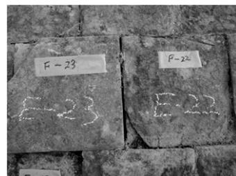
写真-11 石材下部角の破損
