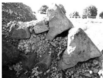
写真-10 石積断面の状況
