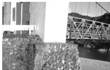
図 3-1 塔柱と粗石コンクリートの接合部
