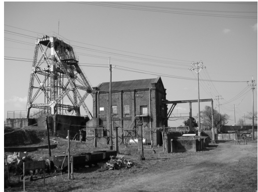
図2 万田坑施設の現況
