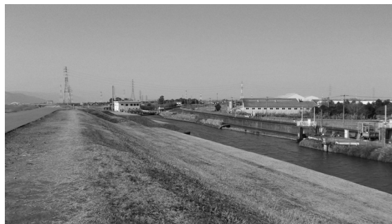
写真-2 木曽川左岸堤防に並行する立田悪水路と海部幹線水路
