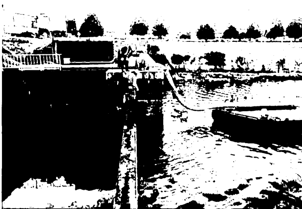
写真6 水抜き作業業況（横利根閘門の角落し支柱に縮切りゲートを設置）
