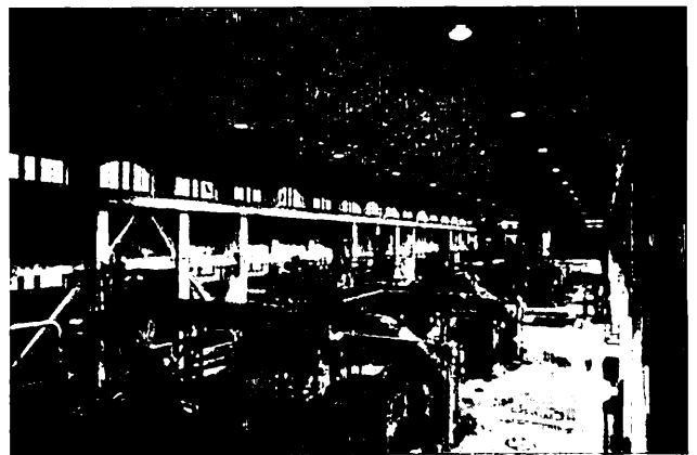
図5 唧筒室内観（内部に10台のポンプが設置されている）
