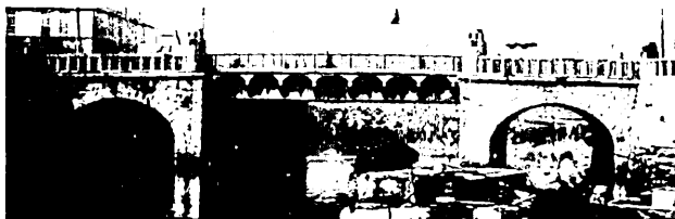
図-9 ラーメン橋台橋 (写真は神田橋 13) )
