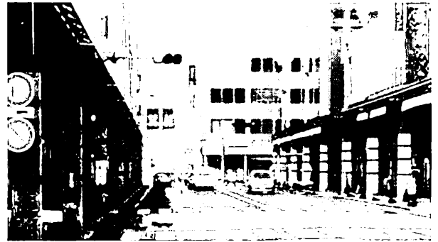
図－2 東地域三条通りの道路幅員の不揃い
