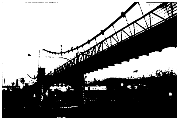
写真-1 玉手橋全景 (撮影：筆者、2010. 08. 25)
