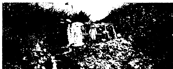
写真-5 旧県営砂防施設 （西谷堰堤 谷積・野面石）
