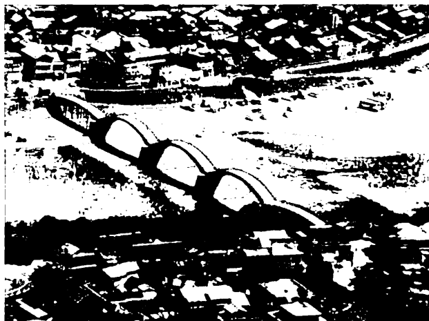
写真1 岩国城から見た錦帯橋
