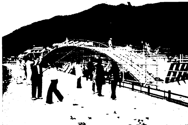
写真6 第一期工事の陸組（おかぐみ）
