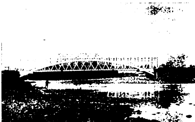
写真-3 ホイラー架橋の豊平橋
