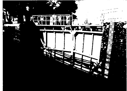
写真-4 閘頭部の門扉の状況（北上運河側右岸から撮影） （撮影：阿部，2011.11.1）
