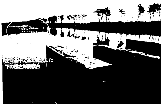
写真-5 新成瀬川下の橋橋台の被災状況 (右岸側から撮影) (撮影：阿部，2011.11.2)
