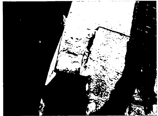
写真-3 閘頭部（右岸側）の隅石の剥離 （撮影：阿部，2011.11.1）
