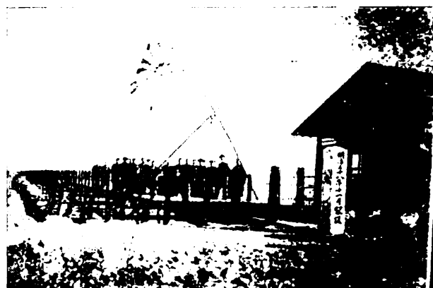
写真-3 民間の活力で建設された常盤橋(島田史料 30) )
