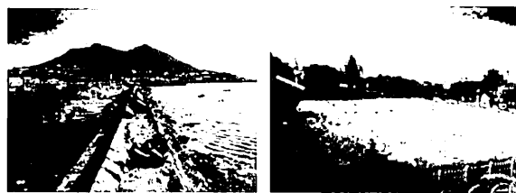
左写真-5 舟入瀬防波堤
