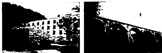
左:写真-1 笹流堰堤、 右:写真-2 旧戸井線了一手橋(寒地土木研究所道南支所撮影)
