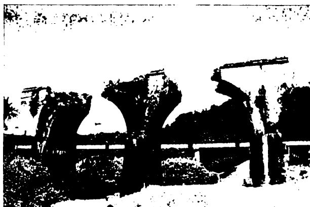
写真-6 龍騰断桥橋
