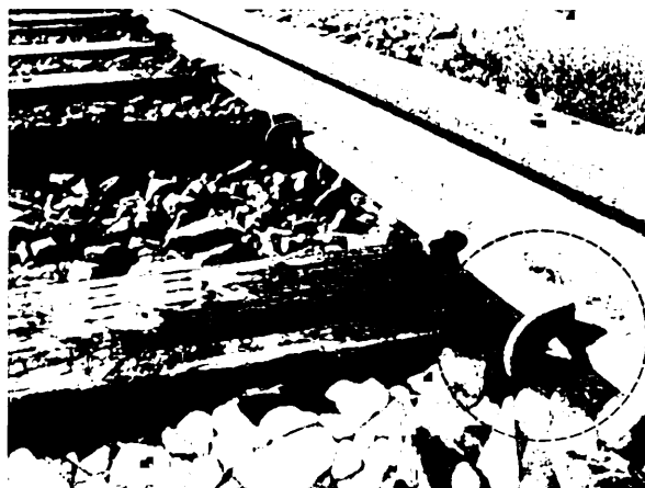
写真-2 木製マクラギ用アンチクリーパ（引用：文献-3）
