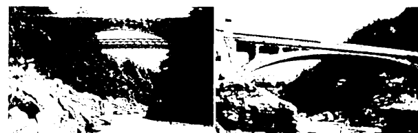
写真11 (左) 姑射橋「天竜川の歩み」天竜川上流河川事務所
