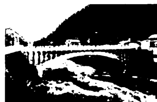
写真9 名栗川橋「土木学会誌」2007年12月 見どころ土木遺産
