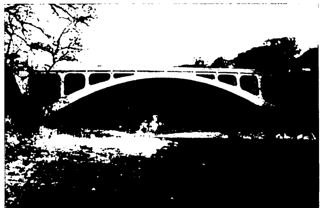
写真1 坂戸橋全景 下流より（撮影：小西、2010）
