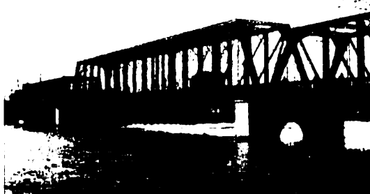
写真-1 旧厩橋／HP Bridge Watchingより
