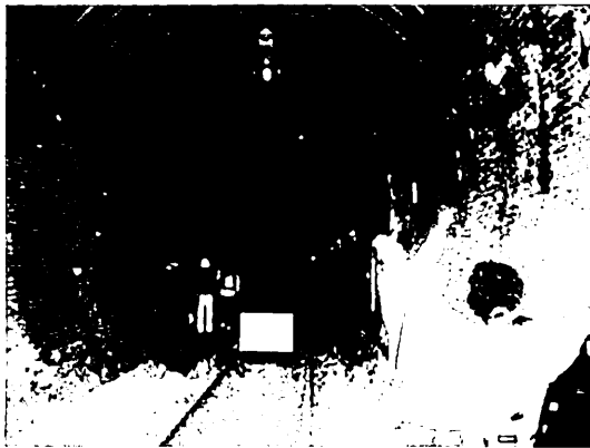
写真-1 大日影トンネル遊歩道内（フットパス時）
