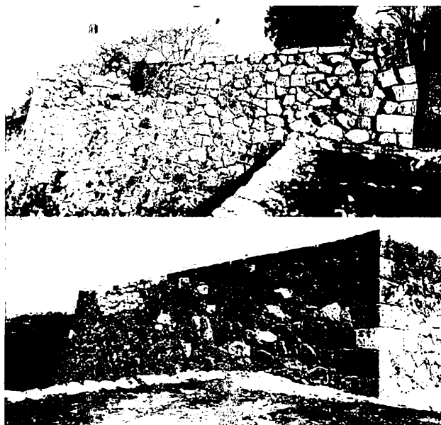
写真 1 五番門南石垣解体修理前後（撮影：平岡正宏）
