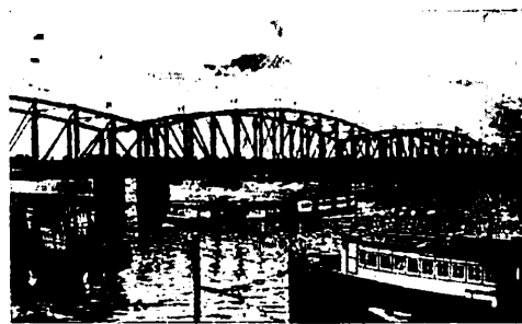
写真-1 旧両国橋/土木学会HP 戦前土木絵葉書 寫真第六十一
