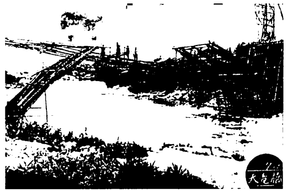
写真 19 天竜橋支保工 20) （飯田市天竜川 昭和 10 年）
