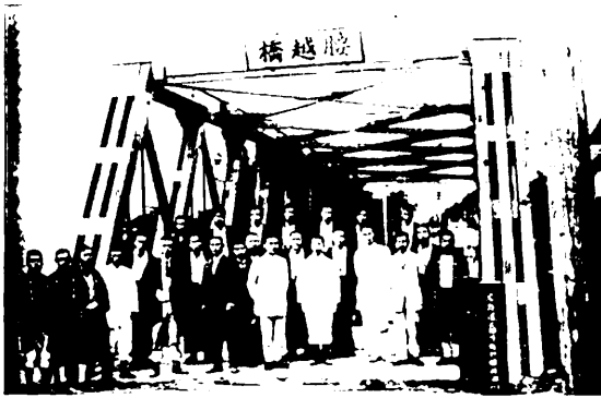
写真9 腰越橋 20) (旧丸子町ハウトラス)
