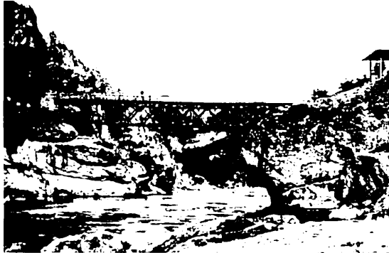
写真11 山清路橋 20) (生坂村ハウトラス上路橋)
