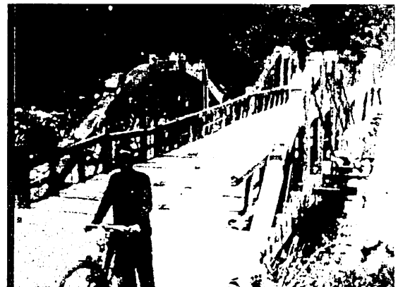
写真14 諏訪形橋 20) (松川町ボーストリングトラス)
