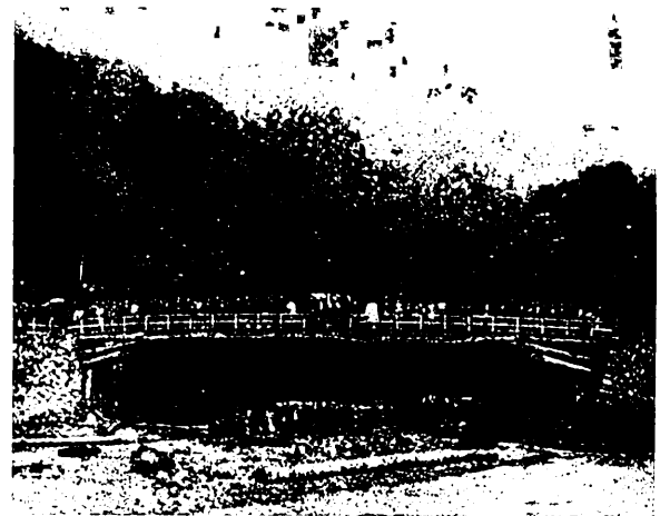
写真8 横川川に架かる篤原橋 (辰野町誌より)
