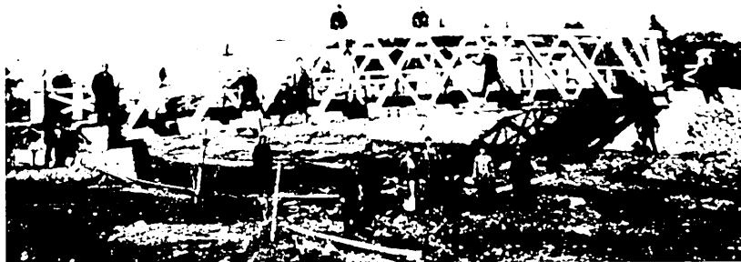
写真1 三州街道改修 小沢川にかかる伊那橋 20) (明治26年 ハウトラス)
