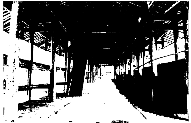
写真-2 永慶橋の路面
