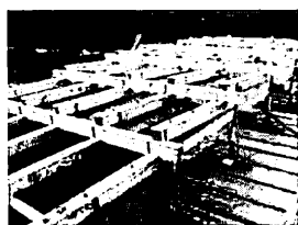
写真-2 ダボ配置の様子
