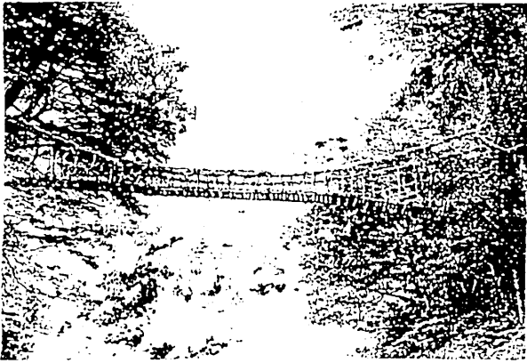
写真—4 高知県香美郡横山村、岡の内葛橋（大正13年） 141)
