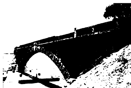
写真2 解体中の平木橋 1 (2008/7/27)
