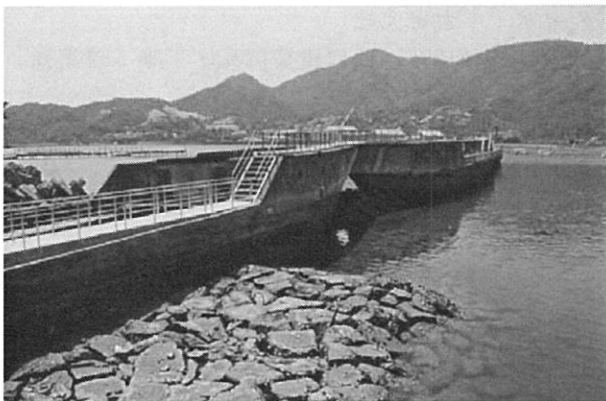
図-12 沈船防波堤：第一・第二武智丸 （呉市安浦町）
