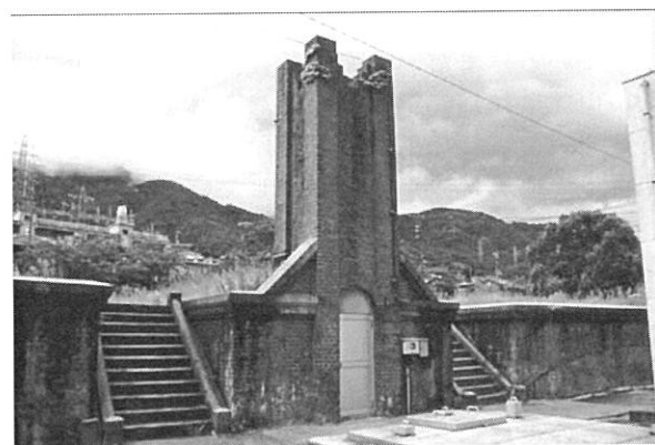
図-9 呉市内に現存する旧軍用水道施設 平原浄水場(1918)
