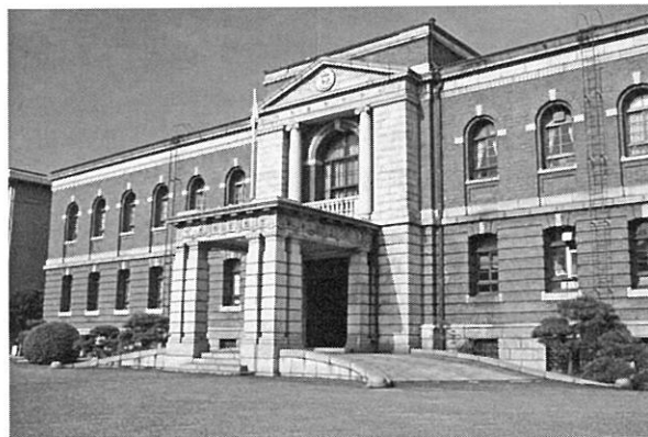
図-7 呉市内に現存する旧海軍工廠関連施設 海上自衛隊呉地方總監部庁舎 (旧呉鎮守府庁舎：1907)
