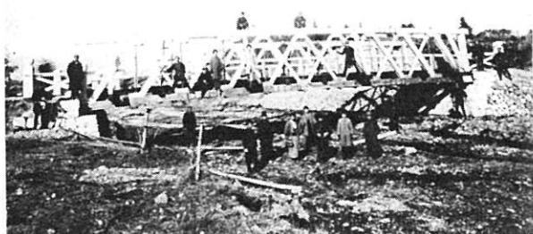
写真-5 三州街道小沢川の伊那橋（ハウトラス） 24)
