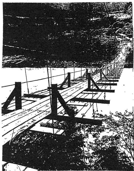
写真一4 前川橋(県道井川静岡線、昭和30年頃) 12)
