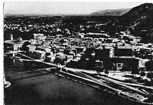
写真-6 トゥルノン橋と城壁(絵葉書より)
