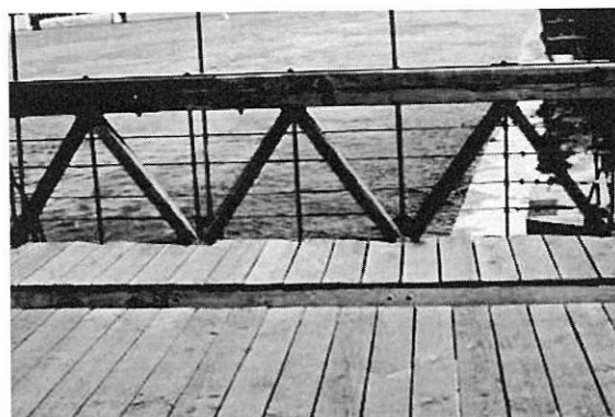
写真-1 トゥルノン橋(撮影：小林)
