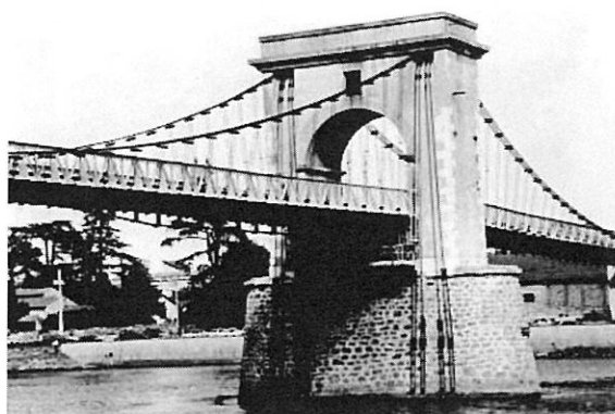
写真-3 アンダンス橋の主塔(撮影：小林)
