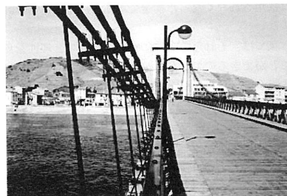
写真-2 トゥルノン橋(撮影：小林)
