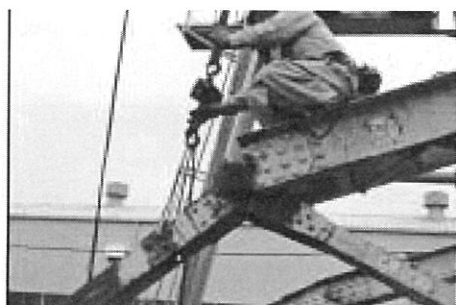
写真-14 上弦材格点部へのピン格納 2005.5撮影
