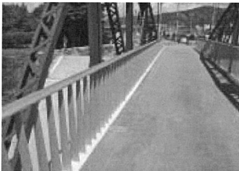
写真-22 高欄と橋面形状 2007.7 撮影
