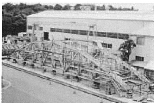
写真-12 再現組立全景 2005.5撮影
