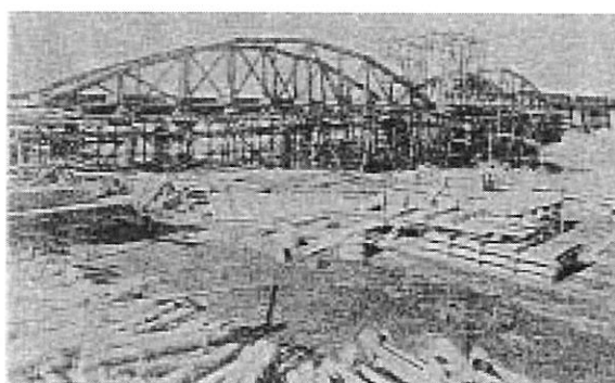
写真-2 昭和3年の架設状況 2)
