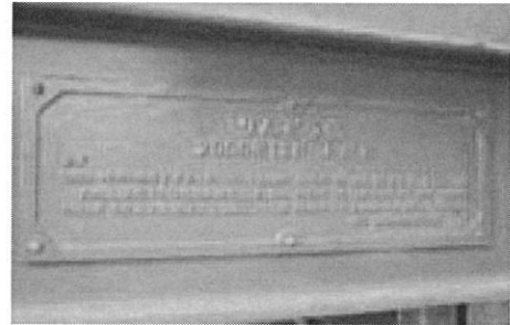
写真-23 橋歴版 2007.12 撮影
