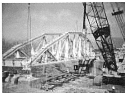
写真-18 撤去状況 2002.1 撮影
