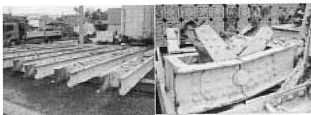
写真-19 (左)部材解体(右)格点切断状況 2002.5 撮影
