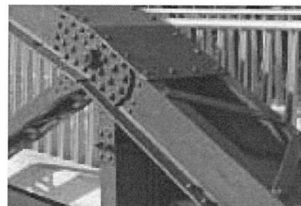
写真-24 左ドイツ製と右国産溝形部材 2007.8 撮影
