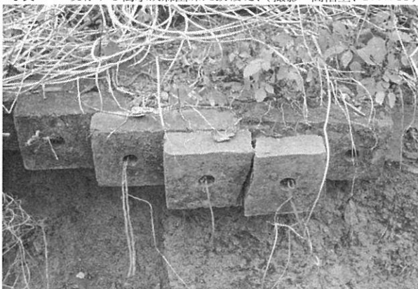
写真-3 現存する濁水溪麻園煉瓦披覆堤、(撮影：簡佑丞、2007.11)
