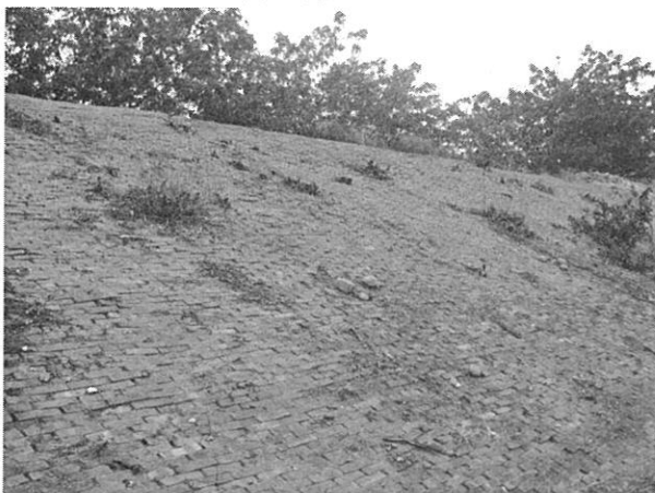
写真-2 現存する濁水溪麻園煉瓦披覆堤、(撮影：簡佑丞、2007.11)
