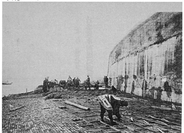
図-6 淡水河堤防煉瓦沈床工事（『台湾に於ける鉄筋コンクリート構造物寫真帖』、1914）
