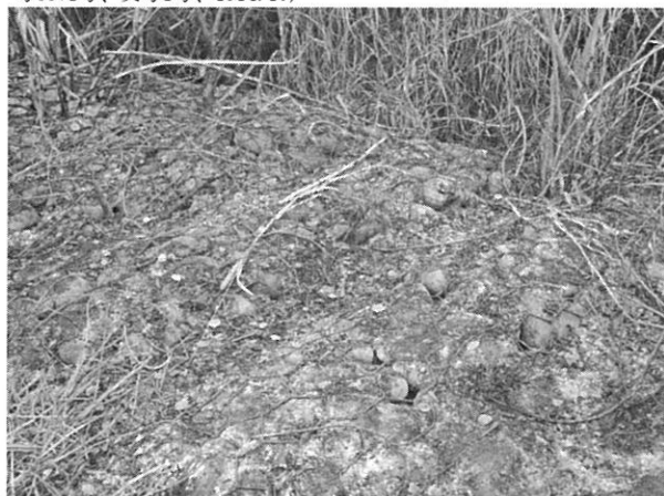
写真-1 現存する濁水溪鉄線蛇籠堤、(撮影：簡佑丞、2007.11)
