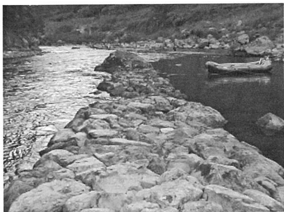
写真-1 朝日ヶ瀬の水寄せ[上流側] (撮影: 著者)
