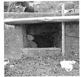
写真3 コンクリートで覆われたコグリ (撮影:筆者)
