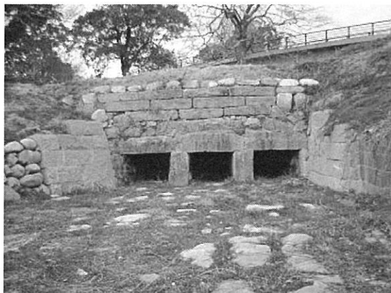
写真8 石井樋取水口
