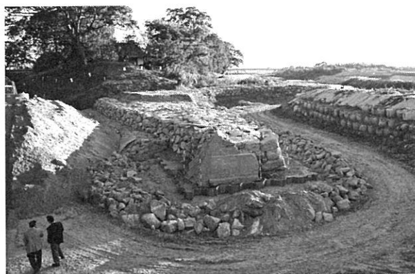
写真3 発掘された天狗の鼻（撮影：吉村） 当時の石積技法で修復された
