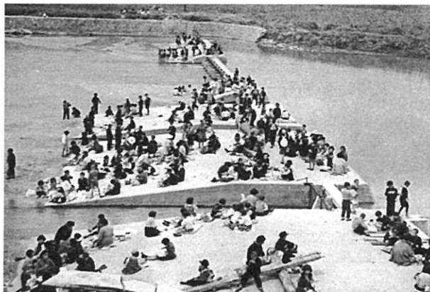
写真1 昭和30年代の大井手堰（佐賀土地改良区提供） 昭和28年にコンクリートで覆われた。
