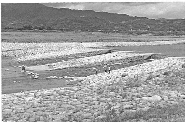
写真2 新設復元された大井手堰（撮影：吉村） 戸立ては転倒ゲートになっている。
