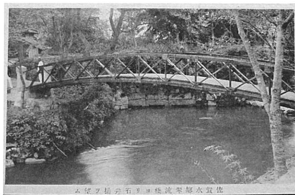
写真7 出鼻（左側）と石井樋（佐賀土地改良区提供）
