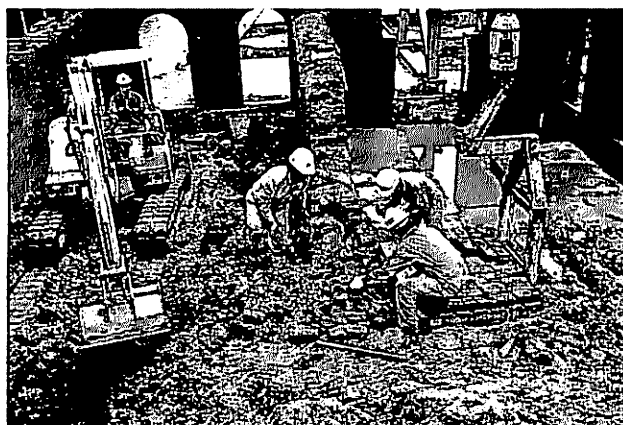
写真-9 埋没煉瓦の回収作業(1 個 1 個拾い上げている) (平成 18 年 8 月 1 日撮影)
