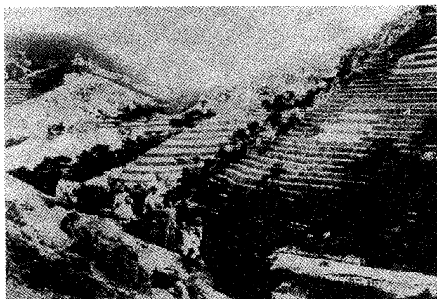
写真-2 再度山の治山事業(明治36(1903)年) 4)
