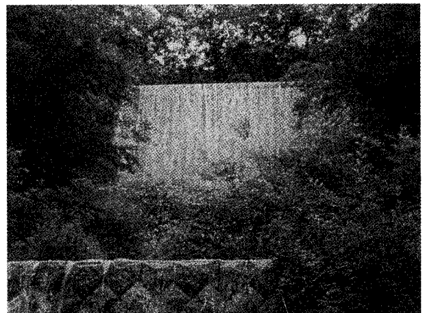
写真-6 直轄第一号の城山堰堤
