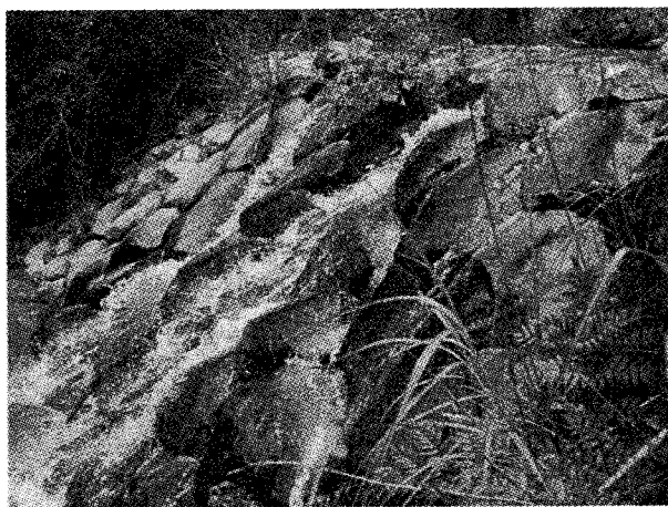
写真-16 座頭谷川支流の巨石堰堤
