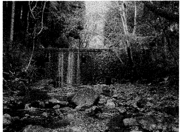
写真-13 岡城川堰堤
