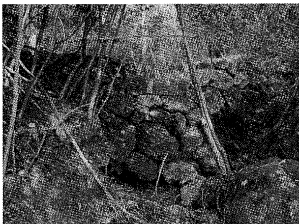
写真-12 市川空積堰堤群
