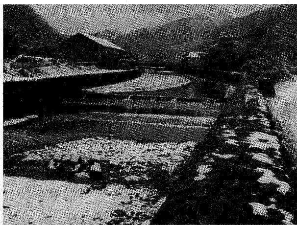
写真-7 出石川流路工群
