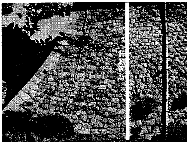
写真-2 名古屋城大天守石垣西面北側 (撮影：森本，2001)
