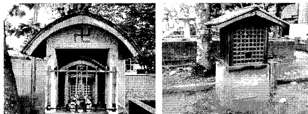
図－4 地蔵堂の現況
