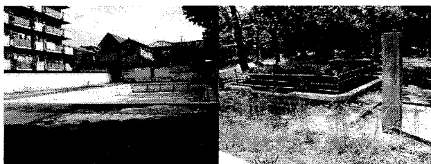
図－3 プールの現況
