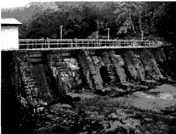
写真2 千歳第1発電所堰堤
