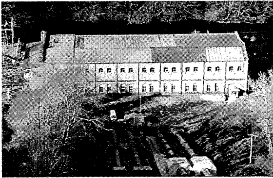
写真1 千歳第1発電所
