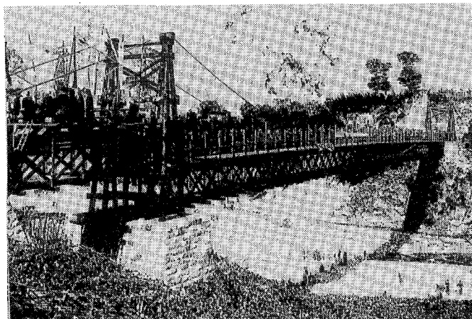
写真一八 山梨県祝橋（大正3年架設、上路式補剛トラスと特異な3本柱4列の門型塔柱） 22)
